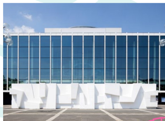
Robert Adams, O.T. (Betonrelief), 1959 (Musiktheater im Revier, Kassenhalle)
